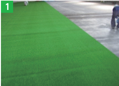
新設人工芝敷設
