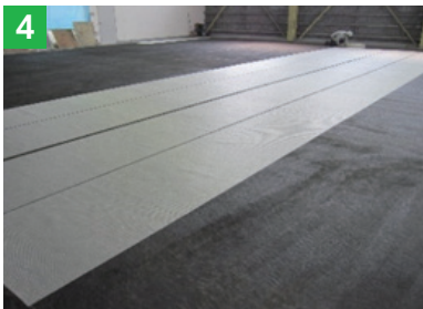
ガラスクロス敷設
